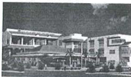
Công ty Xây dựng kiến thiết Kiên Giang
